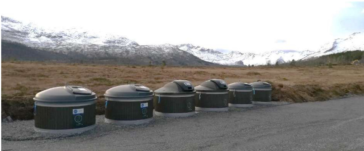
Figur 10. Figuren illustrerer dei ulike storleikane den nedgrave løysinga molok kjem i.
