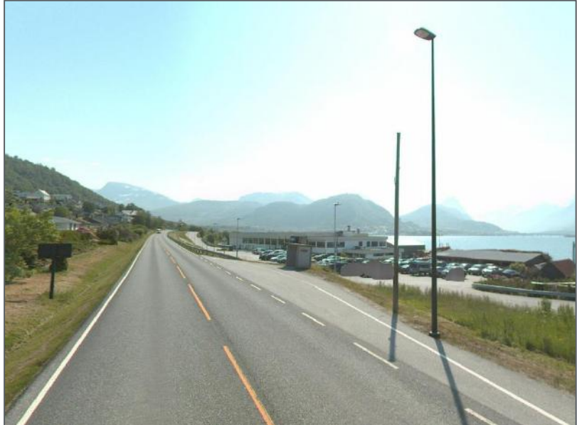
Figur 8 Lyspunkt ved busslomma. Trestolpe med uviss funksjon i bakkant (vegbilder.atlas.vegvesen.no, juni 2023)
