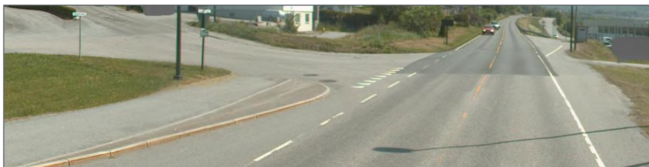
Figur 7: Fv. 60 sett mot aust. Brei skulder i forkant av busslomma (vegbilder.atlas.vegvesen.no, juni 2023)
