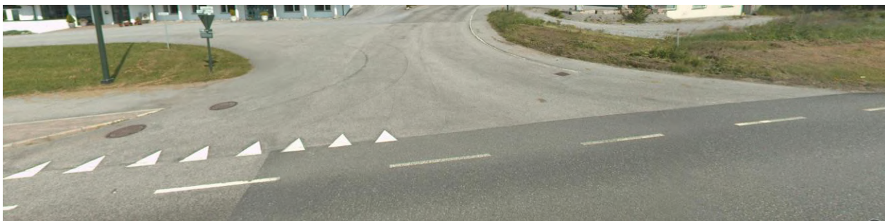
Figur 10: Kryss fv. 60 / Fauskevegen. Manglande kantsteinvis på fortau i Fauskevegen (vegbilder.atlas.vegvesen.no, juni 2023)
