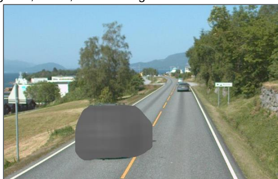
Figur 4: Sikt mot krysset, 120 m avstand (vegbilder.atlas. vegvesen.no, juni 2023)
