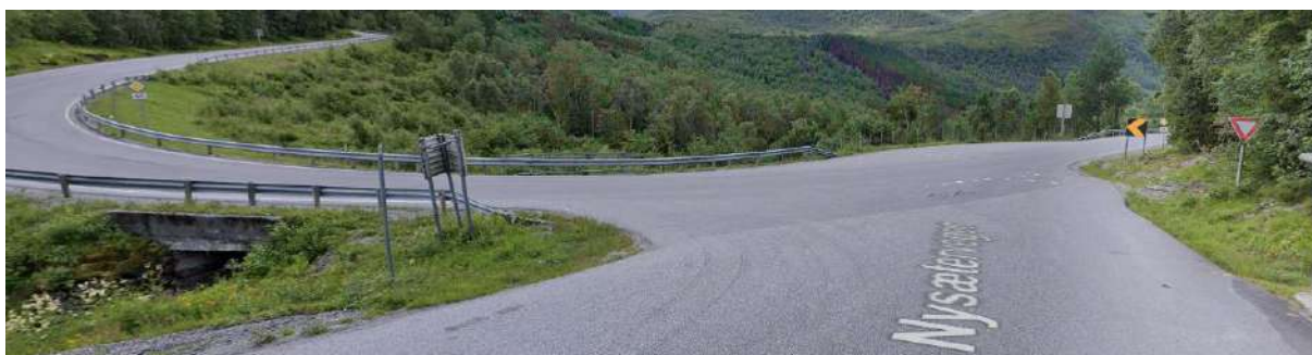
Figur 9 - Skilting av avkjørsel mot fv.60. Kilde: Google Street View (juli 2022)
