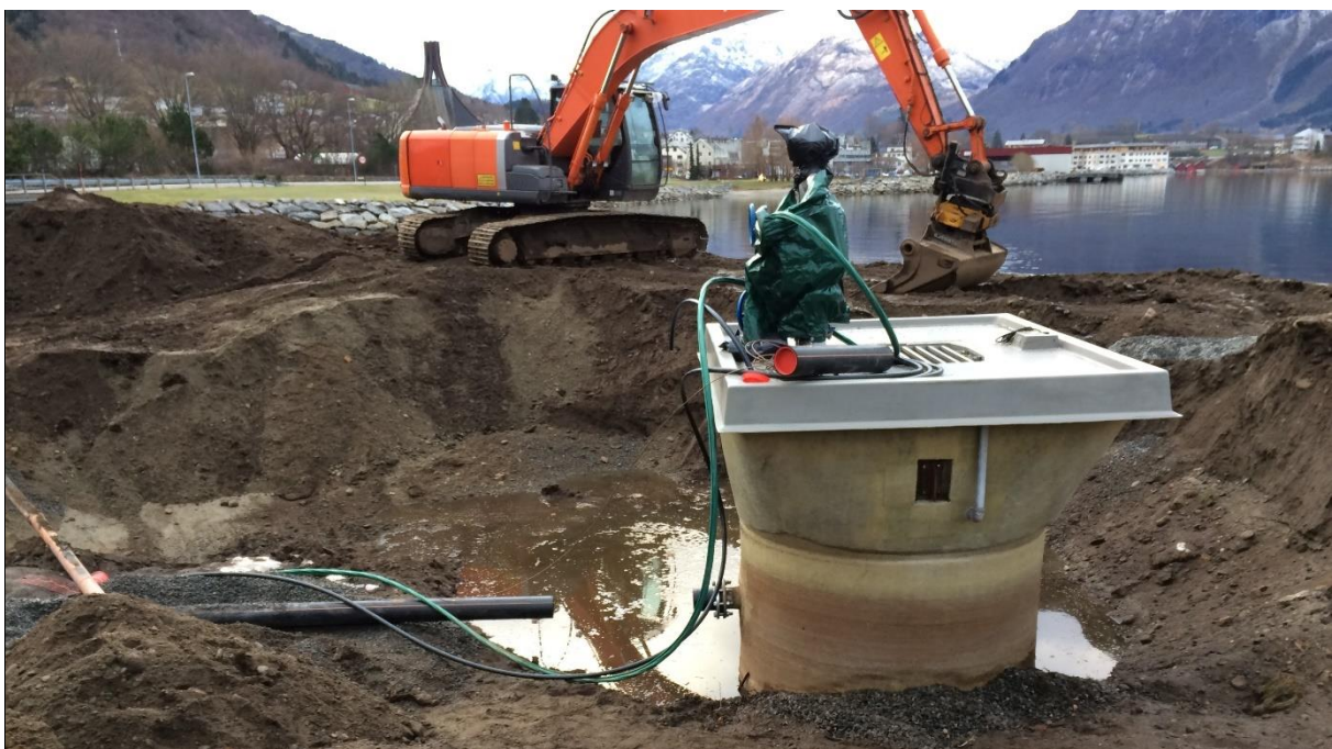
Figur 7 Stasjon for sanering av U127 og U141 (2016, 700 pe)
